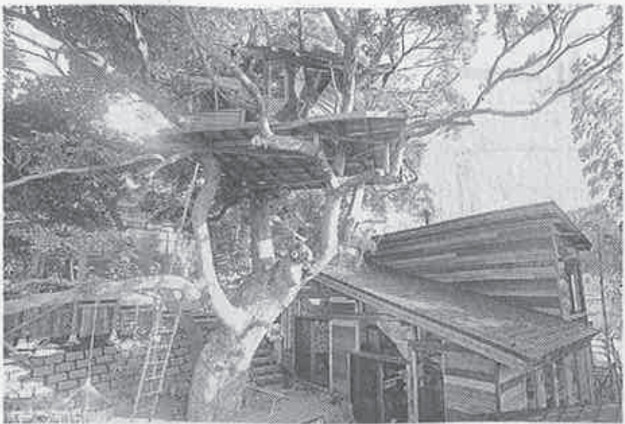
シェアハウス「パウハウス横浜」に建設中のツリーハウス＝横浜市神奈川区で
